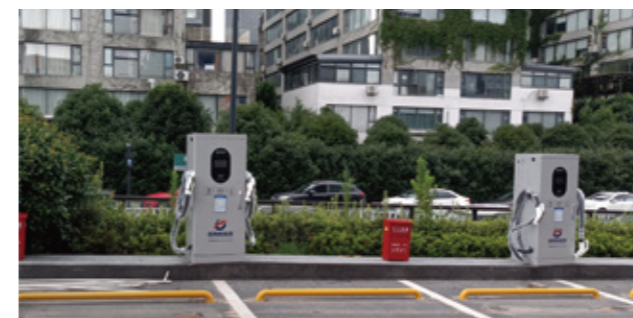
富阳德信产业园
