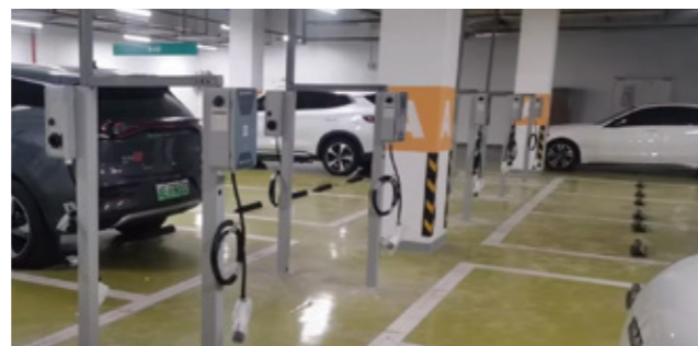
湖州吴兴区人民医院
